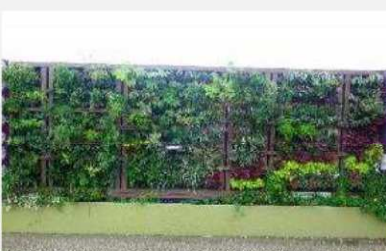
第32回あいちフェア 壁面緑化の技術を 一堂にまとめて展示
