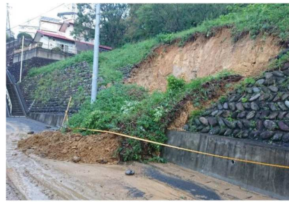
本市における土砂災害（がけ崩れ）の被害 （令和元年東日本台風）
