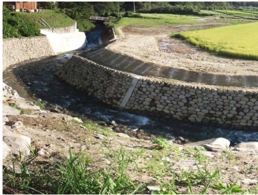
図-〇〇：空積み護岸の整備による 周辺環境への配慮 (多自然川づくり)
