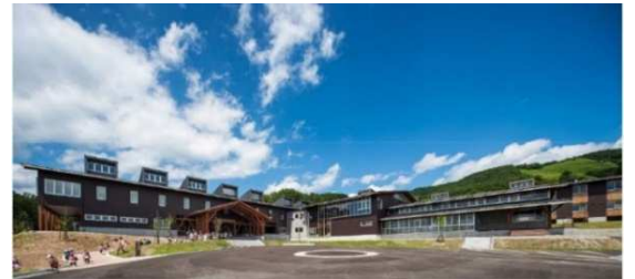
地域産材を活用した木造建築の事例(泉岳自然ふれあい館)
