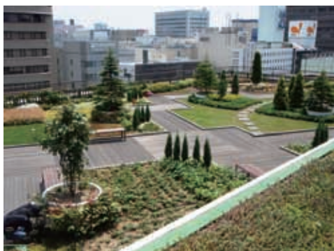
屋上緑化の事例（東北電力ビル）
