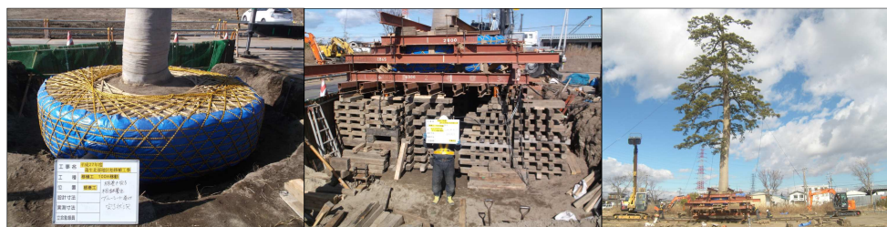
写真2 候補樹木移植状況 (左:根巻、中:ジャッキアップ、右:立て曳き移動)
