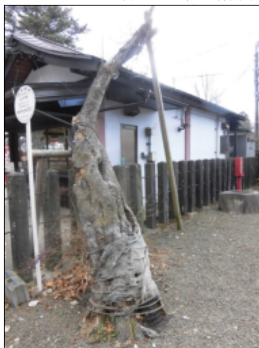
現在の状況 (平成 31 年 1 月撮影)
