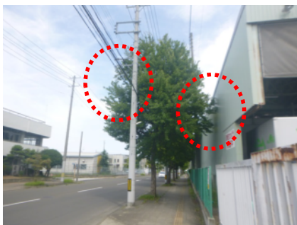
道路空間外への枝の張出し 架空線との干渉
