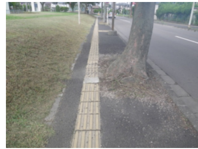
③狭小幅員歩道への植樹樹設置
