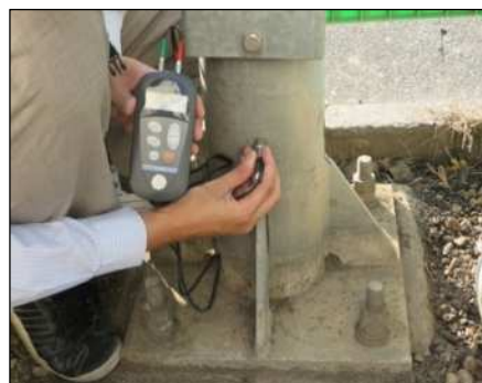
△超音波測定器を用いた板厚調査
