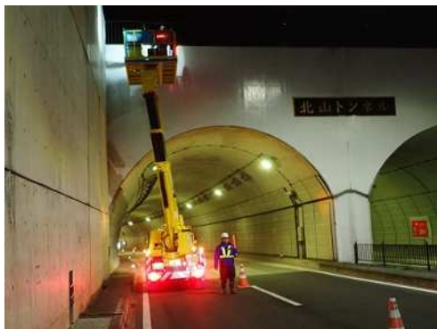
トンネル点検状況
