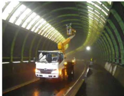
シェッド・シェルター点検状況
