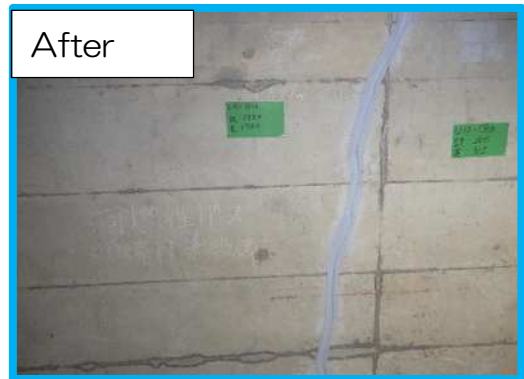
ひび割れ充填工
