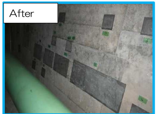
防錆処理工・断面修復工
