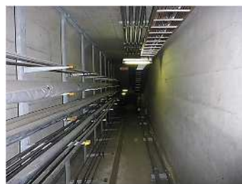
【共同溝内の状況】
