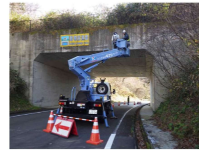
ボックスカルバート点検状況
