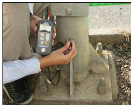
△超音波測定器を用いた板厚調査
