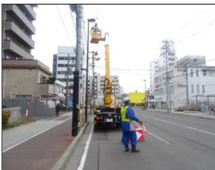
△高所作業車を用いた近接目視点検状況
