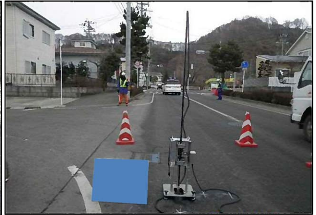
スコープカメラ撮影状況
