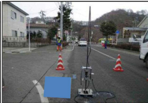
スコープカメラ撮影状況
