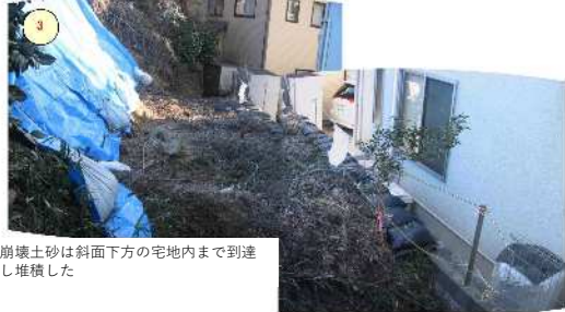
崩壊箇所全景（崩壊の高さは約6.5m程度、崩壊の深さは約0.6m程度の表層崩壊である。）
