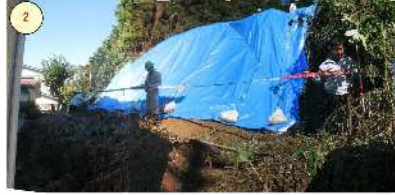
崩壊箇所全景（崩壊の幅は約8.0m程度、崩壊の長さは約9.2m程度の表層崩壊である。）
