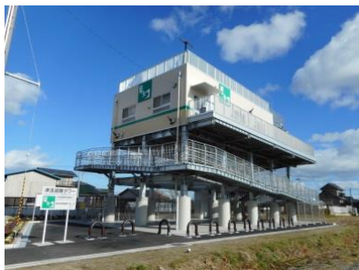
津波避難タワー
