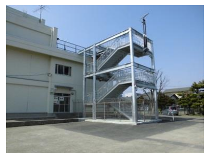
津波避難屋外階段
