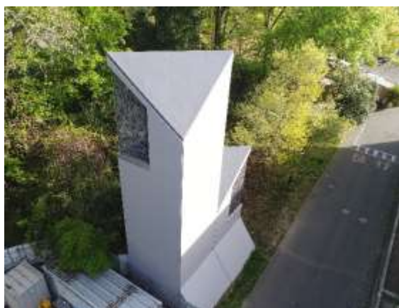
給排気塔（補修・塗装後）
