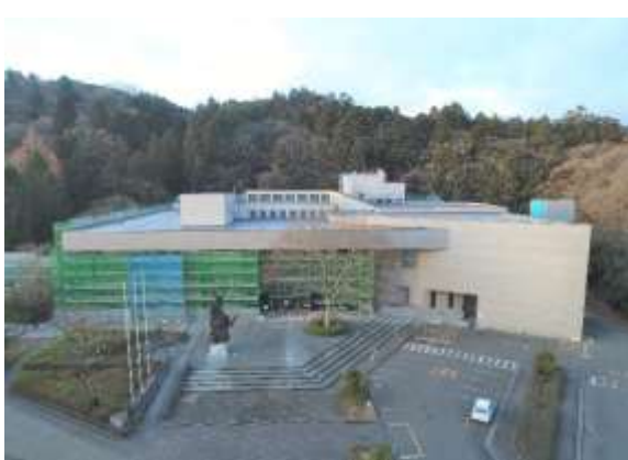
博物館の外観（令和4年12月） （外壁の補修・洗浄後）
