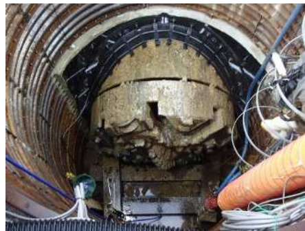
令和5年6月 ミニシールドマシン到達状況
