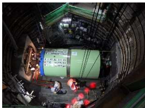
令和5年11月 シールドマシン投入状況
