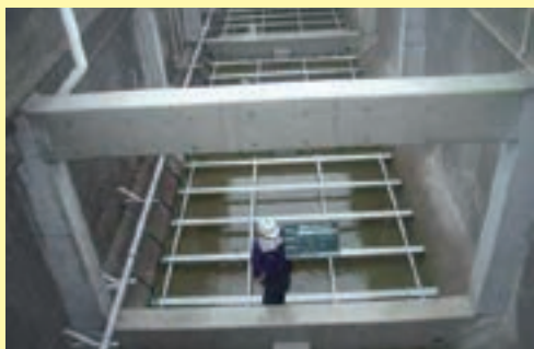
水処理施設の耐震化
