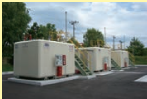
燃料備蓄タンクの設置
