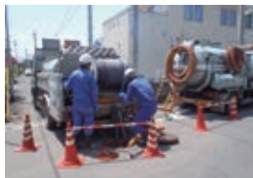
清掃作業の様子
