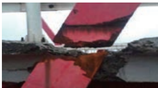
木曾川大橋のトラス斜材の破断（出典：国土交通省）
