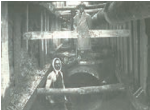
昭和初期における下水道整備の様子
