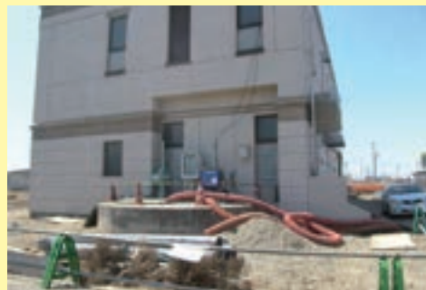
仮設ポンプの設置
