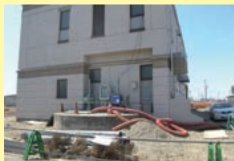
仮設ポンプの設置
