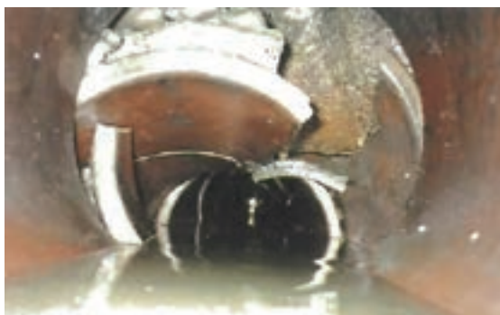
陶管の破損状況（左：本管，右：取付管）
