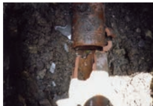
陶管の破損状況（左：本管，右：取付管）
