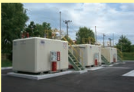
燃料備蓄タンクの設置
