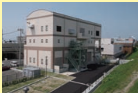
苦竹雨水ポンプ場
