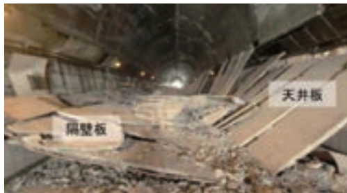
笹子トンネル天井板落下事故（出典：国土交通省）
