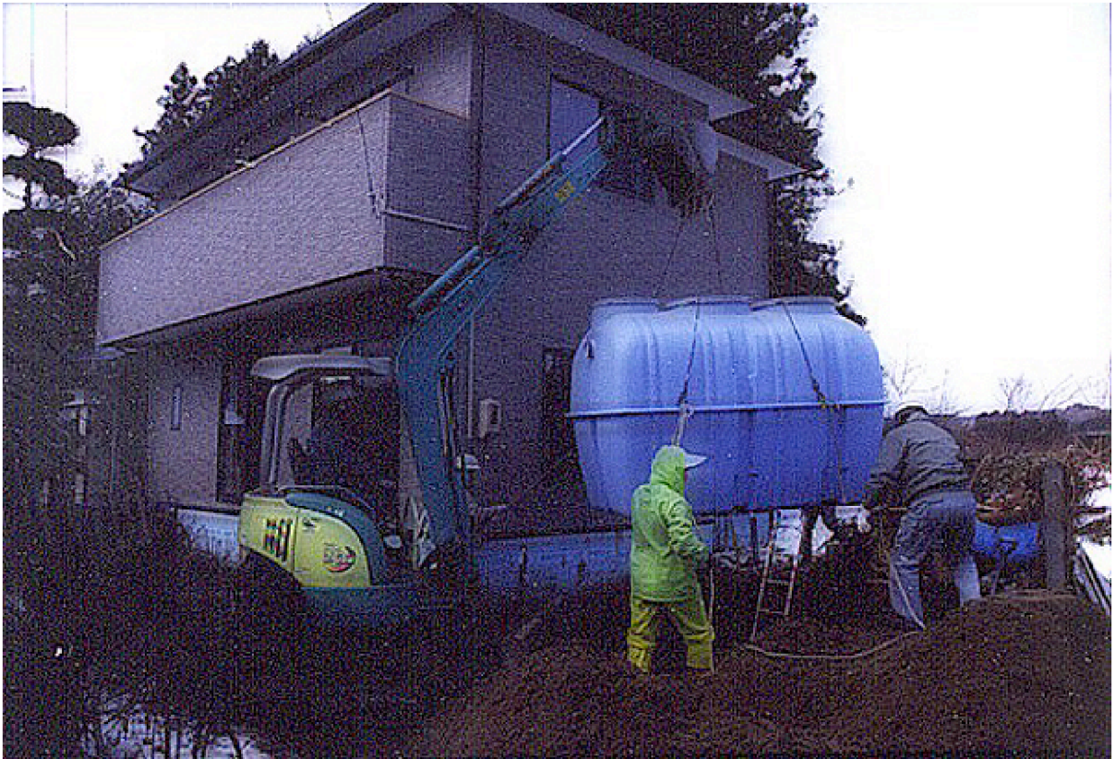
浄化槽設置工事のようす
