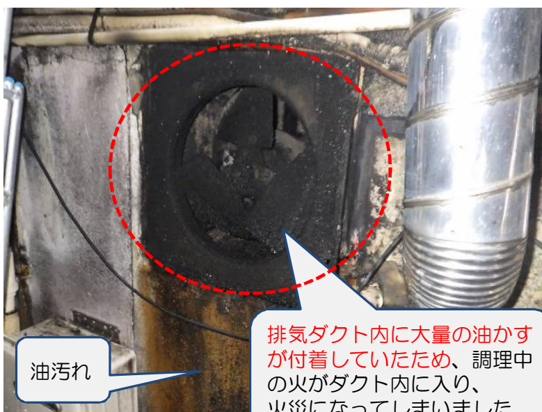
焼損した排気ダクトのファン
