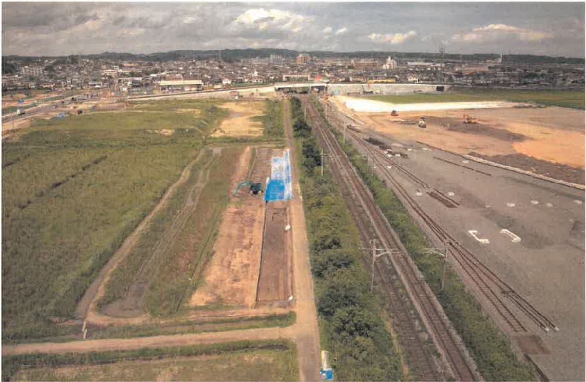
1. 調査区から七北田川方向を望む（南西から）
