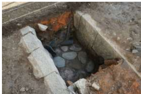
第4図 2区:石組側溝底面(北東から)
