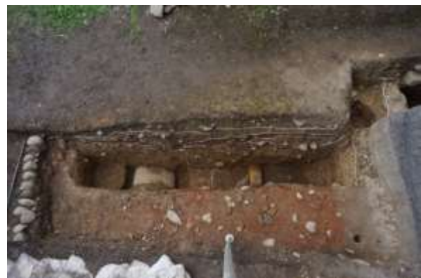
第3図 1区:埋設管設置状況(西から)
