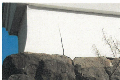
①大手門北側土塀の現状(南から)
