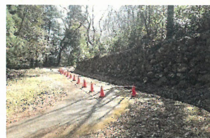
③沢門下石垣の現状(北西から)
