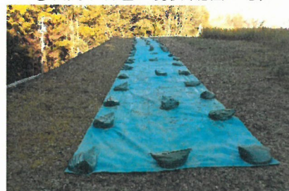
⑤本丸北西石垣天端面の現状(南から)
