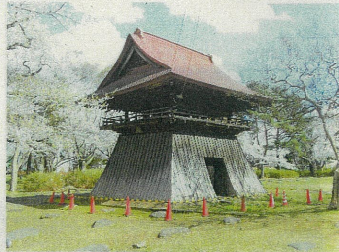
写真1 解体前の鐘楼（北西から）
