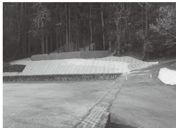
●蛇籠と植生シート等による復旧状況
