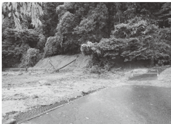
●平成27年9月豪雨の被害状況
