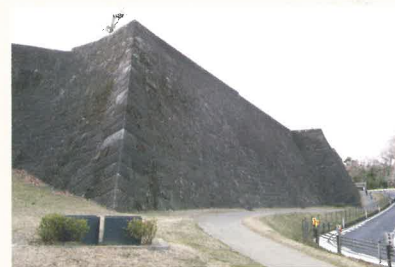
△現在の本丸北壁石垣 この石垣は、四代藩主綱村(1659~1719)の頃に築かれた石垣です。
