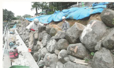
△本丸北西石垣の石垣復旧工事の様子
