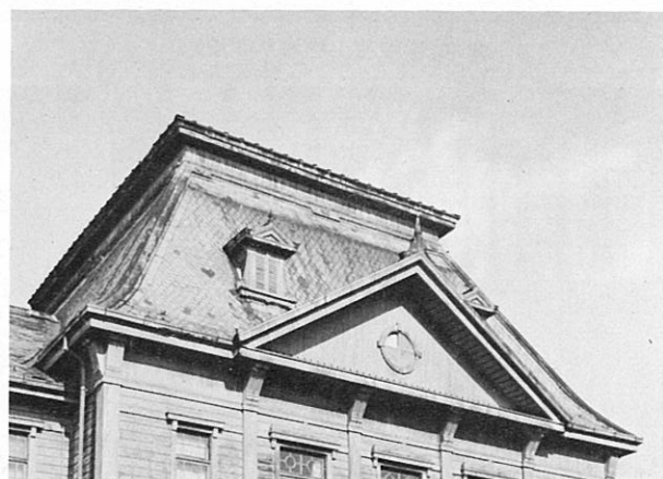
中央部（マンサード・ルーフ式の屋根）
