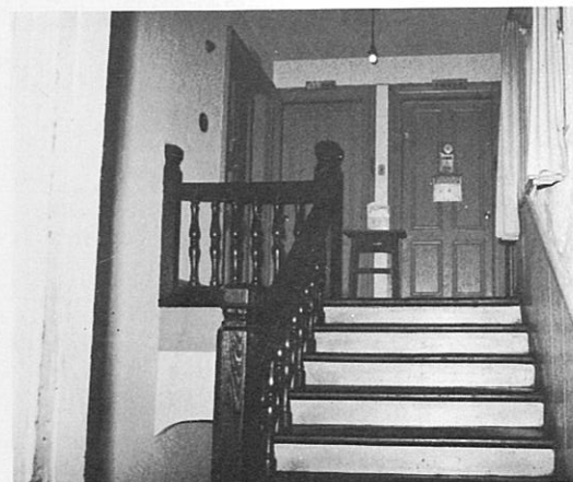
内部(階段及び2階)
