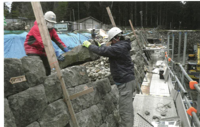
石積み作業 クレーンで吊り上げ移動した石材は、石工さんの手で据え付けます。斜めに立っている板は、石垣を積み直す勾配の基準となる丁張(ちょうはり)という板です。
