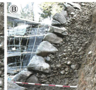
割石・野面石を使用した範囲の裏込め
