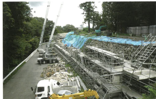
石積み作業 工事範囲には足場を何段も設置します。石材はクレーンで吊り上げ移動します。
