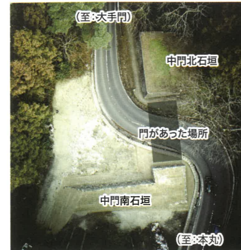
上から見た中門跡(上が北) 登城路は直角に折れ曲がります。南北の石垣の間に門が建っていました。
