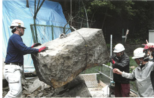
角石の解体作業 約1.8トンある石にワイヤーを掛けて吊り上げます。
