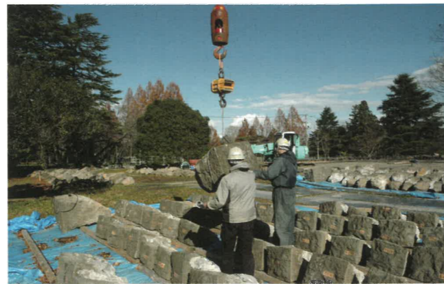
石材置場での石材調査 解体した石材は、大きさ、重さ、加工の特徴などを計測し記録します。
