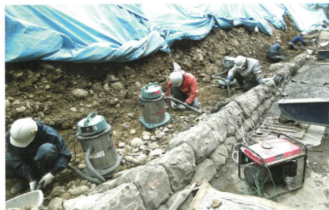
裏込めの清掃作業 解体の途中では清掃作業を行い、石の積み方や裏込めの状態を測量し記録します。
