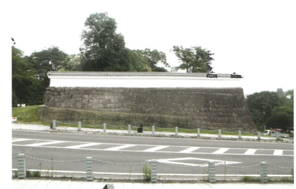
復旧したようす(南から)
