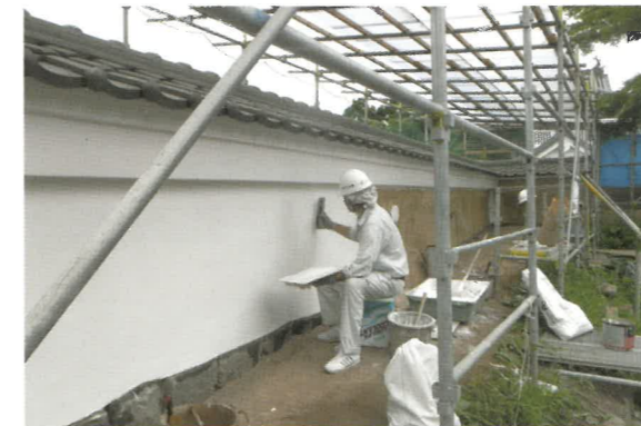
仕上げの漆喰塗り作業
