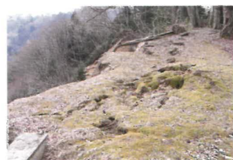
本丸東側崖面に生じた亀裂(北から)
