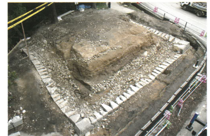
中門北石垣の解体後のようす(北西から) 石垣基部の石材の一部が沈み込み石垣にゆがみが生じていることが分かりました。本来の勾配に戻して積み直すために、一部の石材を交換したり、石の間に敷金(しきがね: 金属の板)を挟み込んで調整しました。
