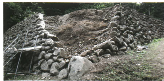
解体したようす(北東から)
