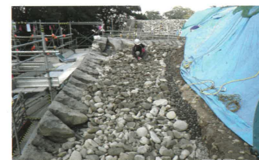
伝統工法による石垣の裏込め
