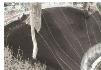
本丸東側崖面復旧工事のようす崩れた崖面に繊維を混ぜ込んだ土を吹き付けて補強しています。
