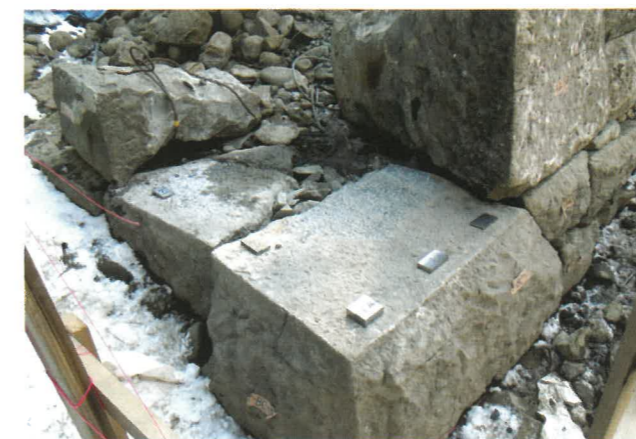
敷金を置いたようす(北西角部) ステンレスの板を置き、上の石を少し持ち上げ勾配を調整しました。
