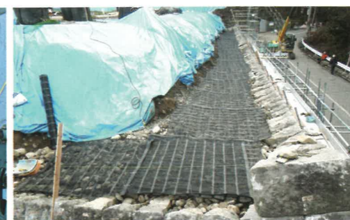
一部で施工した現代工法(ジオテキスタイル)
