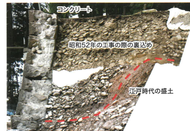
中門北石垣の裏込め断面 石垣の石はコンクリートで固められていました。昭和52年(1977)の積み直し工事でコンクリートが使われたようです。今回の復旧工事では、コンクリートを使わない伝統工法で積み直しました。
