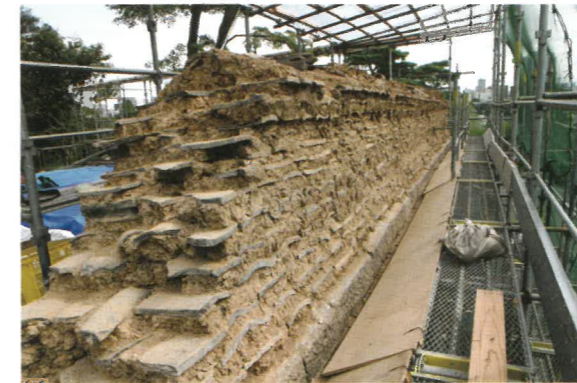
土塀の躯体部(西から) たくさんの瓦が水平に敷き込まれています
