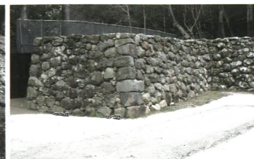
西門石垣の修復状況
