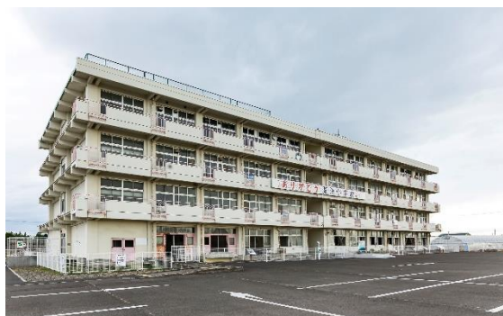
震災遺構仙台市立荒浜小学校
