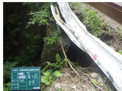
災害復旧工事（崩落箇所）
